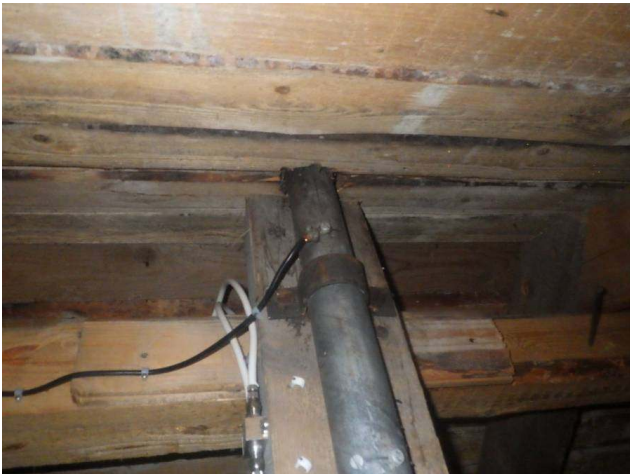
38. Antenniputken läpivienti, ei vuotojälkiä
