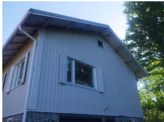
17. Julkisivua autotallin päädyssä
