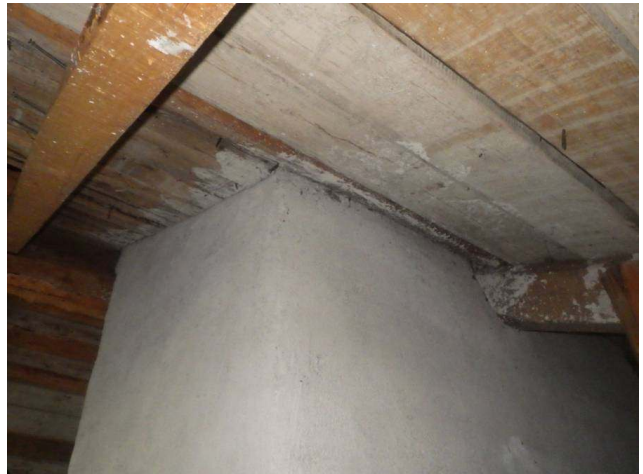
39. Savupiipun läpivienti, ei vuotojälkiä
