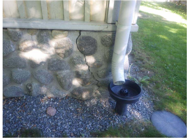
15. Kattovesien ohjausta ja salaojan tarkastuskaivo
